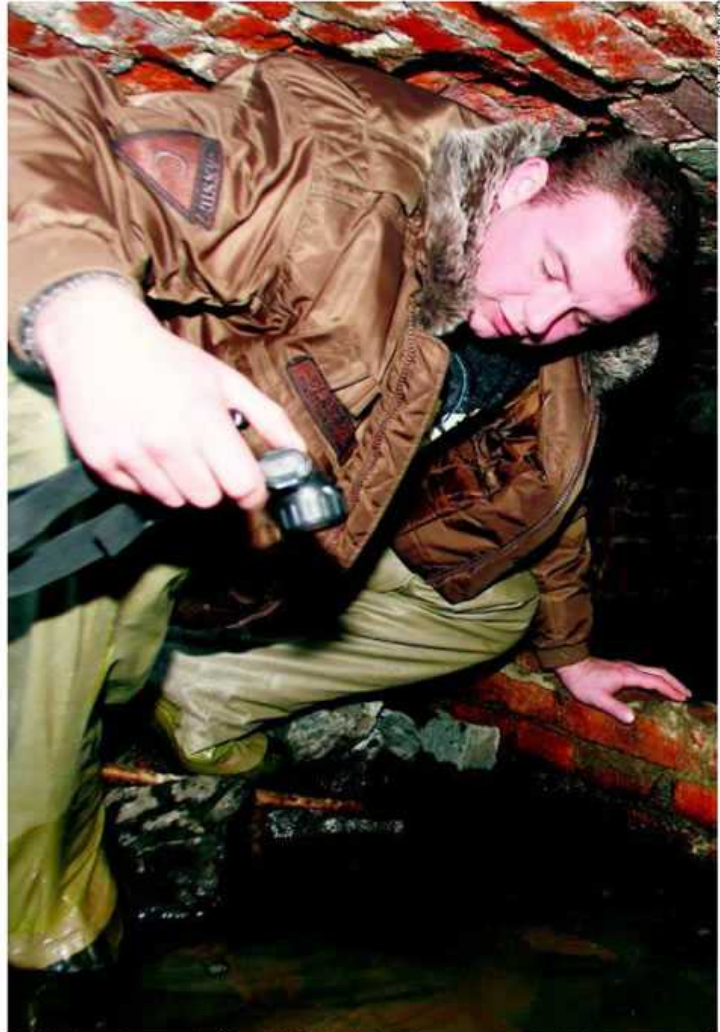
Bunkier jest zalany wodą. Żeby dokładnie obejrzeć jego wnętrze, trzeba ją wypompować
